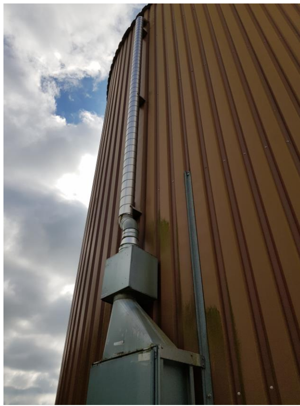
Billede fra montering af ny rørføring m. preplader
