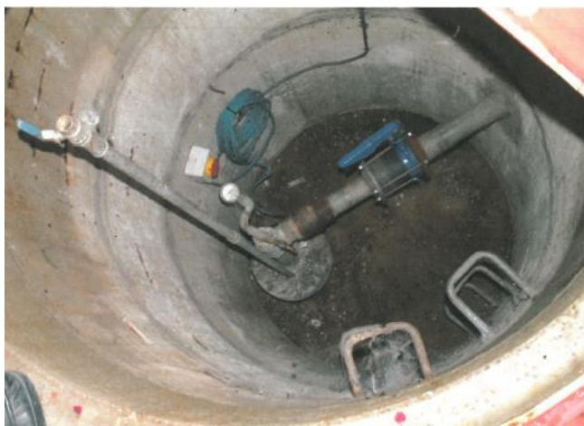
Boringer før renovering
