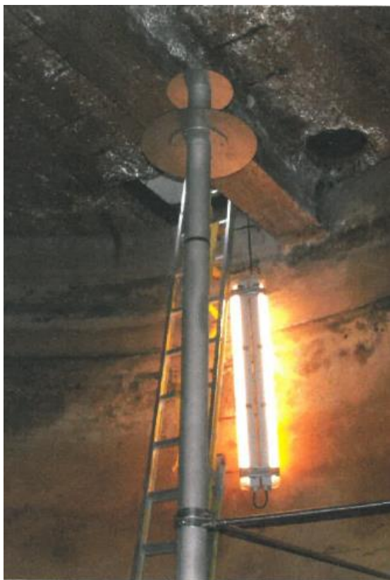
Billede fra montering af ny rørføring m. preplader
